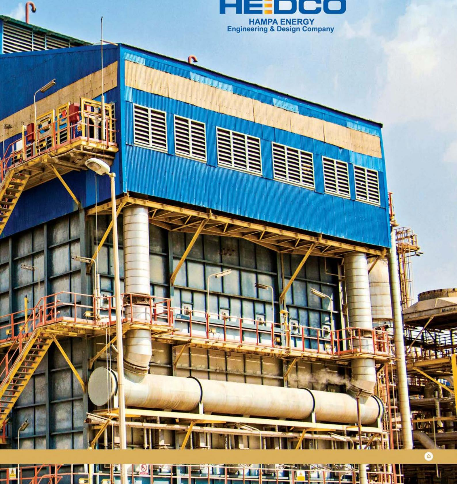
بخش اصلی ریفرمر، شامل تعداد زیادی تیوب می باشد که در واقع به عنوان قلب ریفرمر عمل می کند. این تیوب ها توسط کاتالیست پرمی شود و گاز متان به همراه بخار آب با عبور از روی این کاتالیست ها در دمای نزدیک به 1000 درجه سانتی گراد به مولکولهای هیدروژن و مونوکسید و دی اکسید کربن تبدیل می شود.
